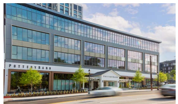
Der Holzneubau „619 Ponce“ wurde im April 2024 eröffnet
