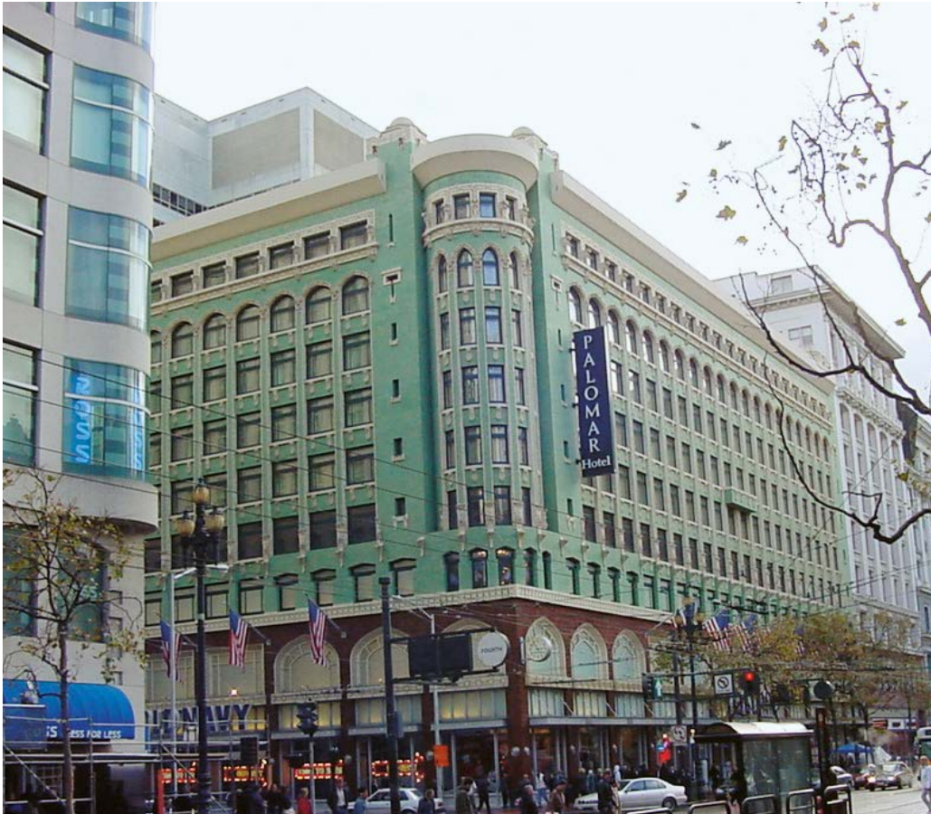
Gemischt genutzter Gebäudekomplex, Pacific Place, 801 Market Street/22 Fourth Str., San Francisco, Kalifornien Baujahr: 1907/1981 Mietflächen in qm: 39.972 Verkauft am 30.11.2011
