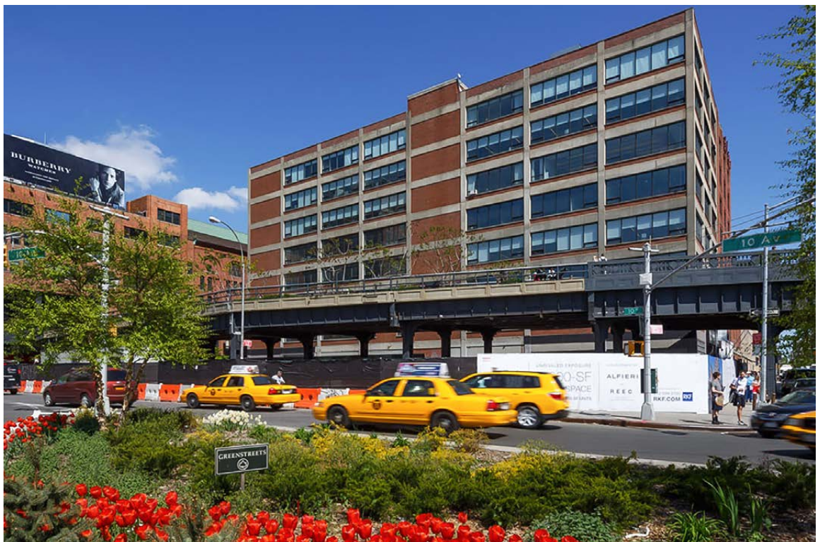
Geschäftshaus Milk Studios, 450 West 15th Street, New York City, New York, USA Baujahr: 1936/1971/2004 Mietflächen in qm: 30.217 Verkauft am 22.05.2019
