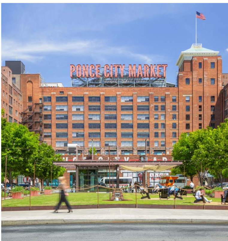
Bestandsgebäude Ponce City Market
